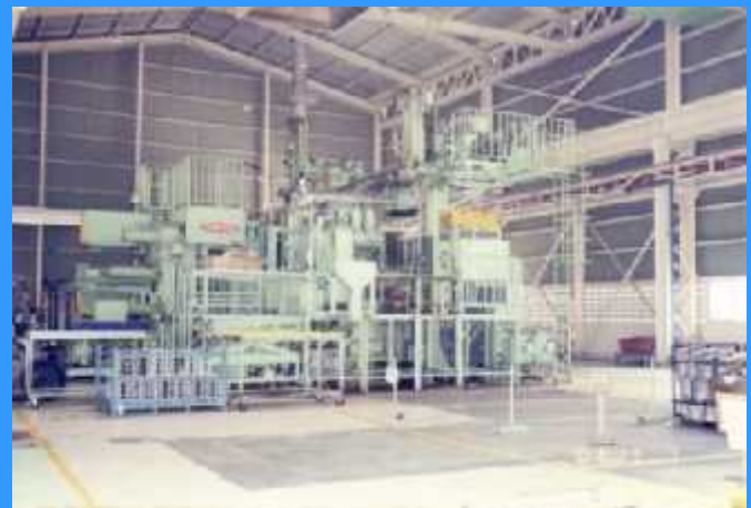
Installation for 1.600 Ton Die Casting Press Machine
